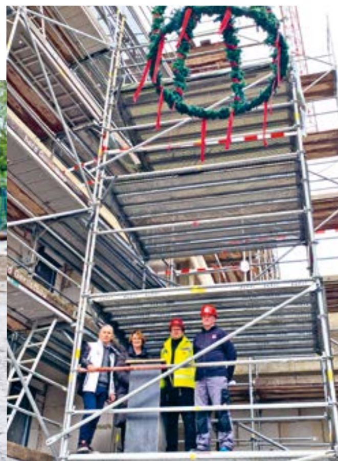
(Von links): Marco Moretti (moretti wohn- und bauprojekte GmbH) Gabriele Gropp-Stauth (Staudt Architekten) mit Emanuel Koch und Klaus Schneider (beide Köster Bau) beim Richtfest des Wohncarrés Wilhelmstraße in Braunschweig.
