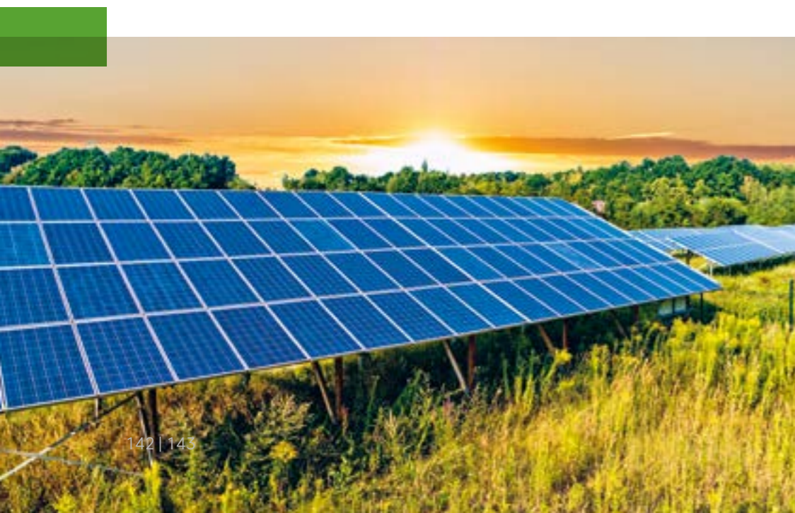
Die Erzeugung grüner Energie durch z. B. PV-Anlagen bietet Landwirten eine neue Einnahmequelle und macht die Betriebe unabhängiger von der Ernte.
