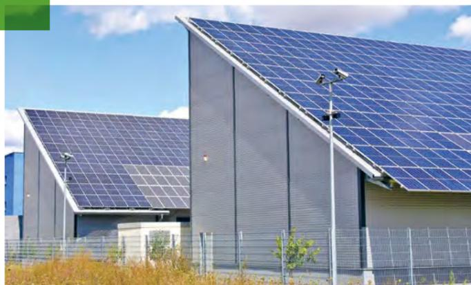
Dachflächen von Gewerbebauten ermöglichen mit großflächigen Photovoltaikanlagen eine effiziente Erzeugung von grünem Strom.
